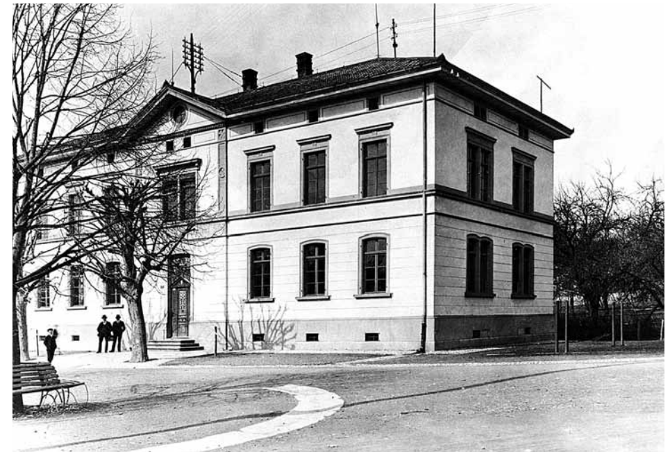
Schulhaus mit Dachständer (Vor der Aufstockung 1920)
