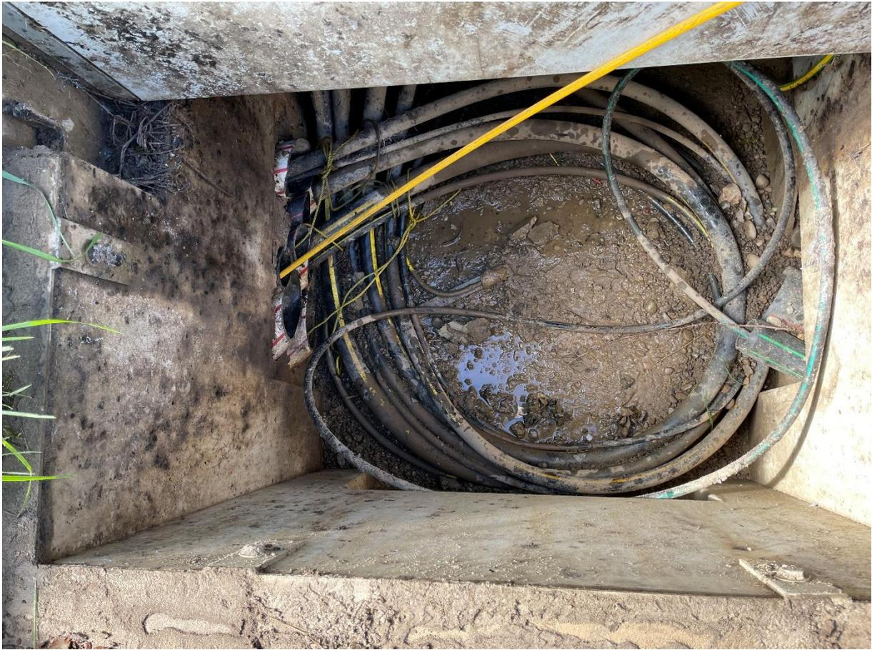
Blick in den Kabelschacht. Geschlaufte Elektrokabel und Rohre, gelb Einzugsrute im Leerrohr
