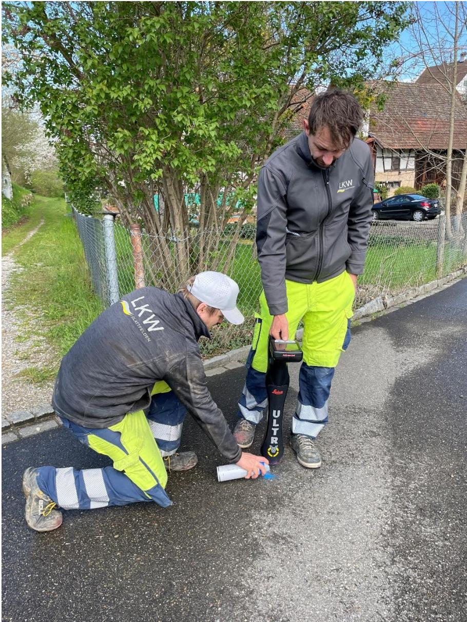
Richtung des Leerrohres ist bestimmt und wird markiert
