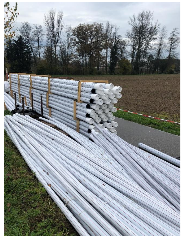
Zum Einbau bereit
